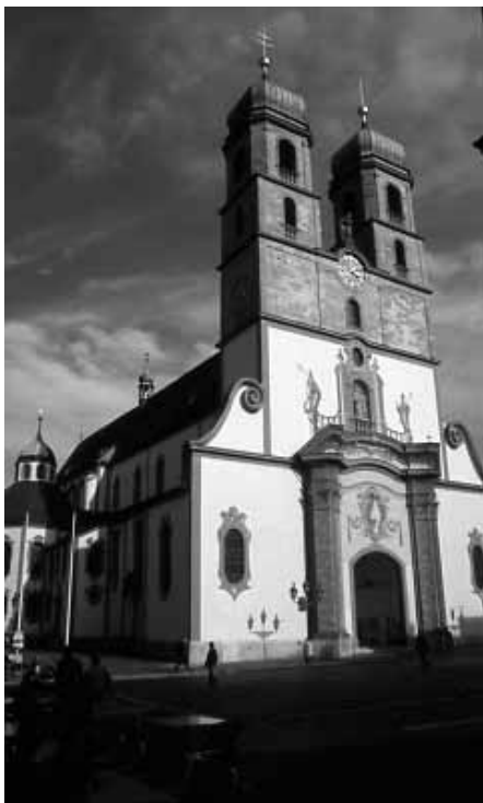
Abb. 3: Bad Säckingen, Fridolinmünster. Westfassade mit dem von Johann Kaspar Bagnato um 1740 neu gestalteten Hauptportal. Die kräftig akzentuierte Rahmenarchitektur schließt als Supraporte eine reich gefasste Kartusche mit dem Wappen der Auftraggeberin, Fürstäbtissin Maria Josepha Regina von Liebenfels (reg. 1734–1753), ein. Foto: Patrick Bircher
